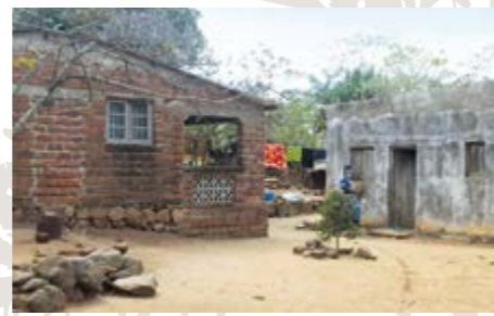
Vorher: Die heruntergekommenen Gebäude laden nicht zum Lernen ein.
