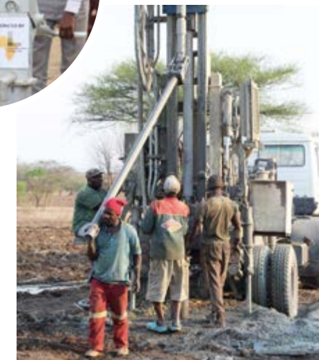
Die Dorfgemeinschaft half vorab mit, die Zufahrtswege für die schweren Baumaschinen zu ebnen.
